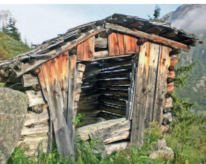
einräumige Barge, Heuschober Bp. .1395; 1788/89, Erweiterung durch verschalte Ständer-Riegelkonstruktion 1853; Stangenschrot
