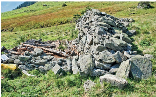
Wüstung Barge Bp. .1309, Trockenstützmauer als Lawinenschutz; westseitig abgegangener Unterstand an Barge Bp. .1304
